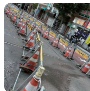
赤羽駅西口の下水道工事
